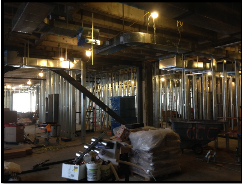
Bldg A Lvl 1: Metal Stud Framing
