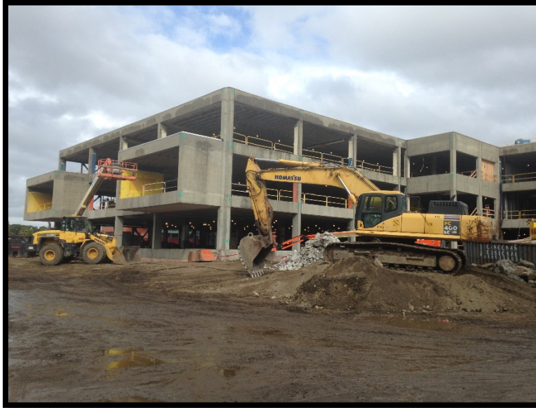
Bldg A: Exterior Demo
