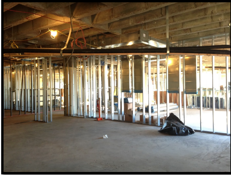
Bldg B Lvl 3: MEP Rough-In
