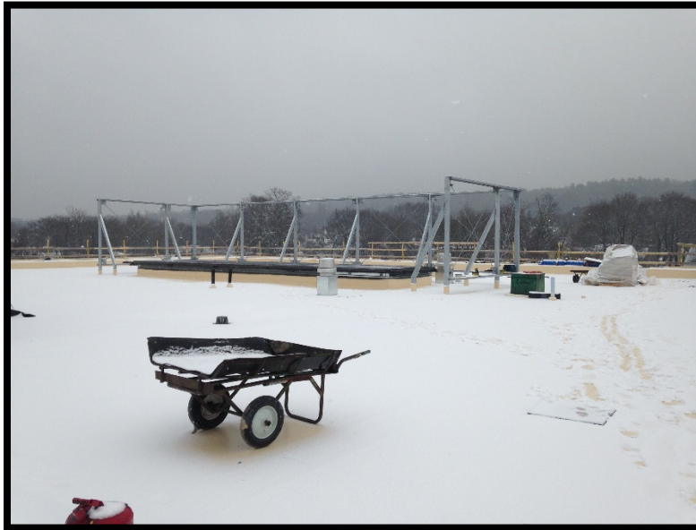
Bldg B Roof
